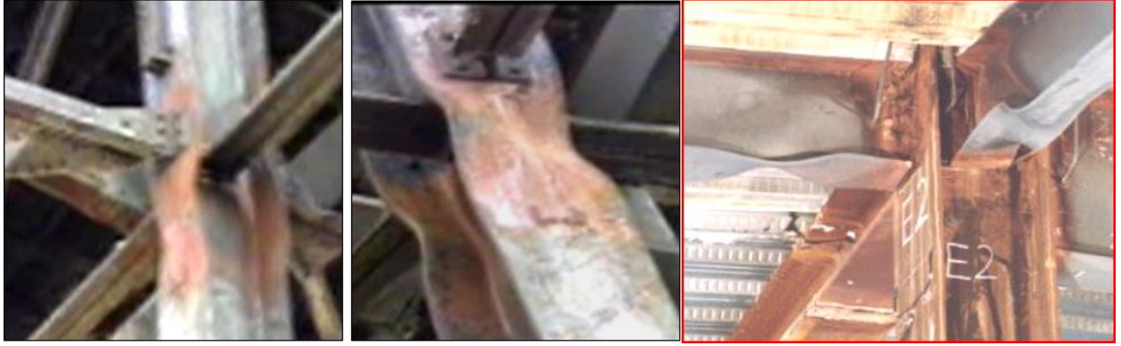
Şekil 4: Çelik çerçevelerde düğüm noktası deprem hasar örnekleri
