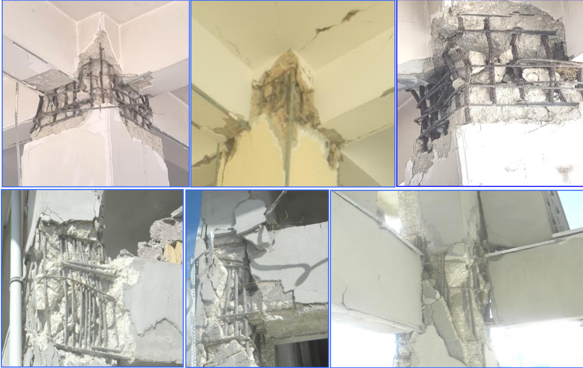
Şekil 3: Düğüm noktası deprem hasar örnekleri
