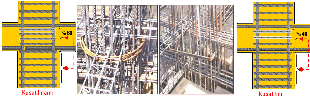
Şekil 8: Kolon-kiriş birleşim bölgesi kesme donatısı miktarının etkisi
