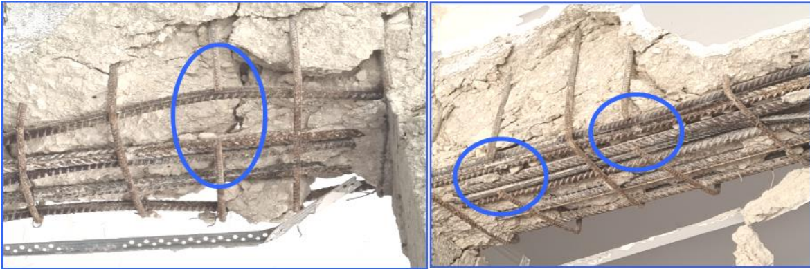
Şekil 1. Depremde kopan etriye hasarı
