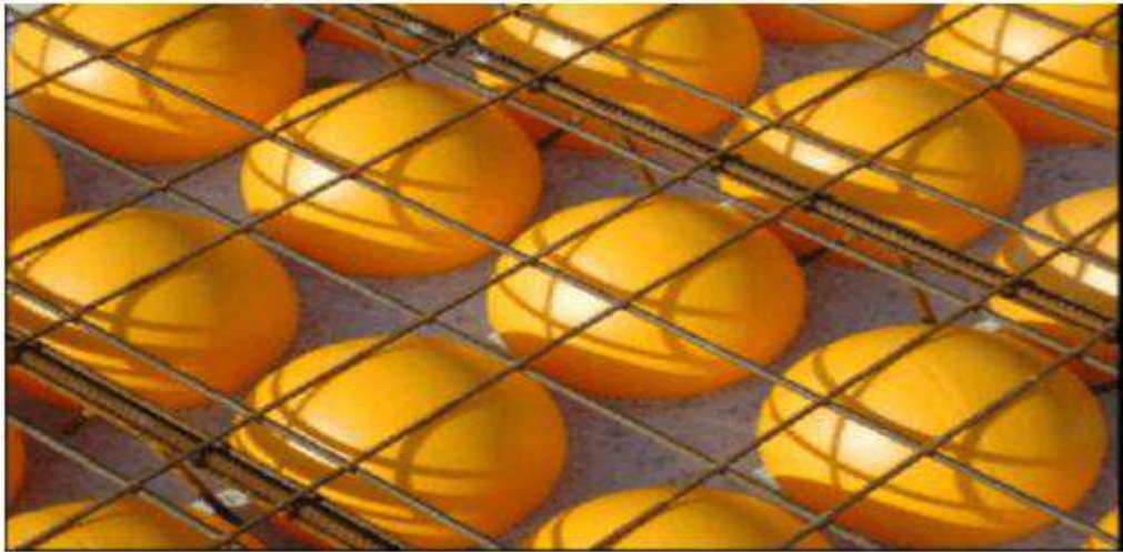
Şekil 5. BubbleDeck firmasının döşeme sistemi [2].
