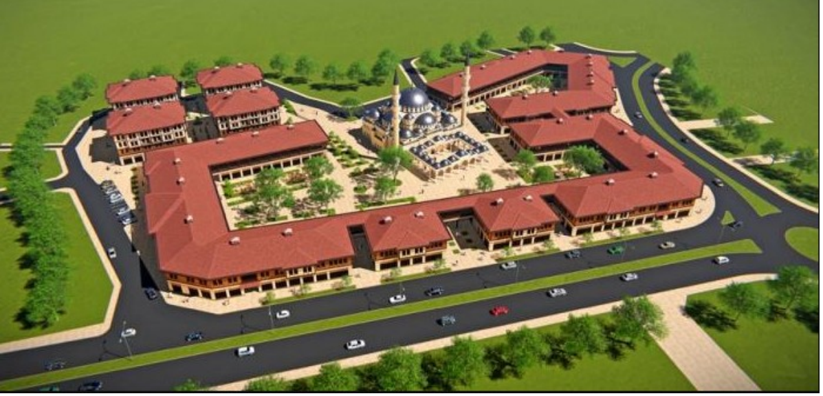
Şekil 12- Erciş Kentsel Dönüşüm Genel Görünümü (Hekimyaşı,2018)
