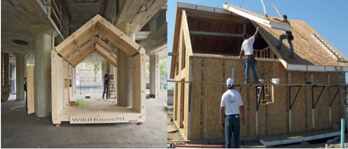
Şekil 16- Açık Kaynak Evlerinde Yerinde Montaj Uygulamaları
