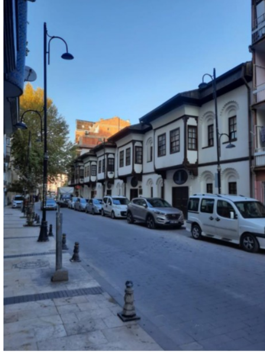
Şekil:1 Beş Konaklar (2. Yapı) Cephesi
