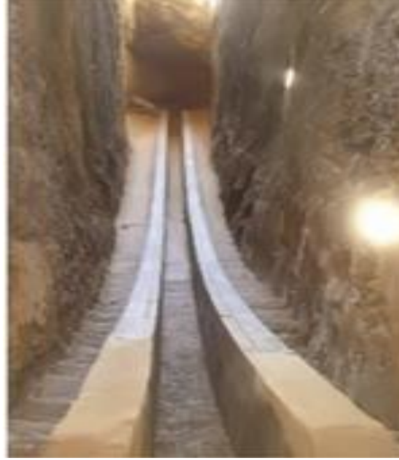
Semerkant Gözlemevi'nin içine oyulmuş el-Fahri sekstant aleti 85
