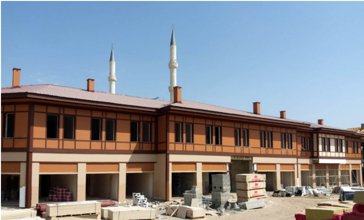
Şekil 10- Erciş Kentsel Dönüşüm İnşaat Görünümü (Hekimyaşı,2018)
